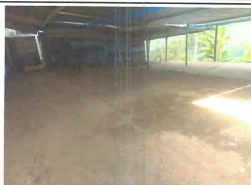
Foto 2: Se sustituirá el piso del corredor del centro educativo con piso de granito.
