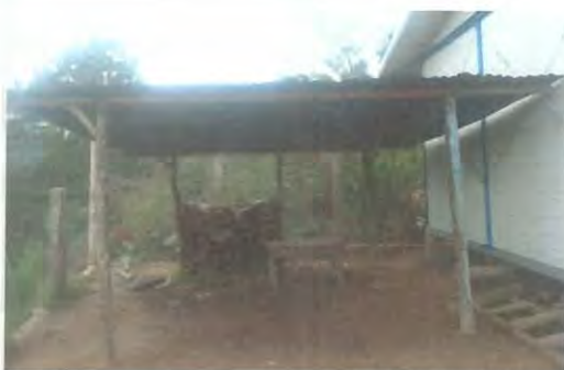
Foto 3: Mejoramiento de galera cocina con sistema pórtico (tubos y costaneras metálicos) y techo con lámina troquelada
