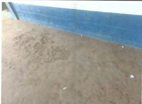
Foto 1: Se sustituirá el piso del corredor del centro educativo con piso de granito.
