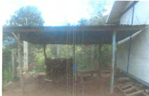
Foto 4: Instalación de tres hiladas de block + cimentación y solera en el perímetro de la galera cocina.
